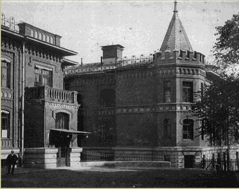
Здание клиники Института питания в 1941-1945 гг.
